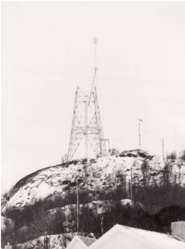
Telemasta på Varberg under montering våren 1968. Foto: Alf Fagerheim/DF
