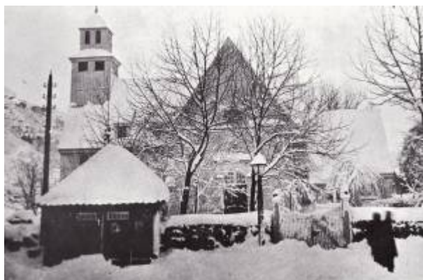
Sprøytehus nr 2 ved kirka. Foto: E. H. Torjusen/DF
