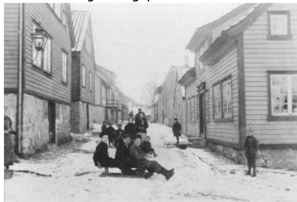
Nygaten sett mot sørvest. Foto: Ukjent/DF
