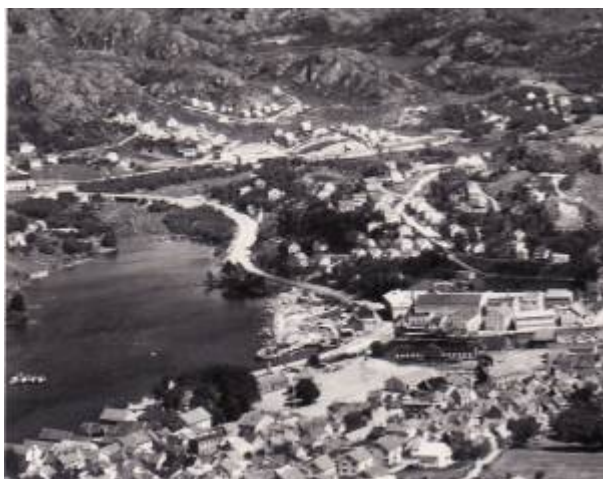
Jernbaneveien under bygging i 1956. Foto: Widerøe/DF (Utsnitt)
