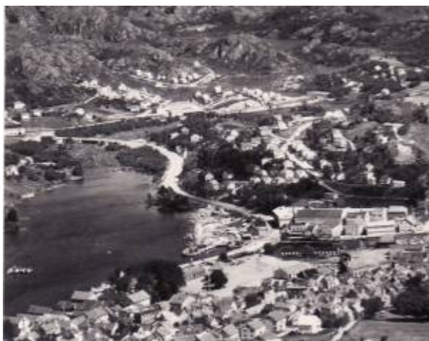
Jernbaneveien under bygging i 1956. Foto: Widerøe/DF (Utsnitt)
