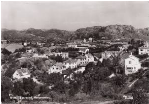
Hafsøyveien. Foto: Mittet/DF
