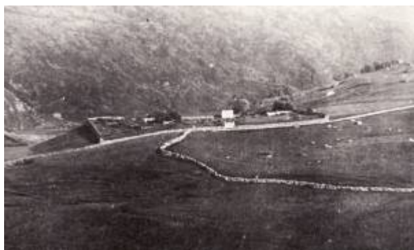
Gravplassen ved Gamle Prestegårdsvei 1885. Foto: E. H. Torjusen/DF (Utsnitt)
