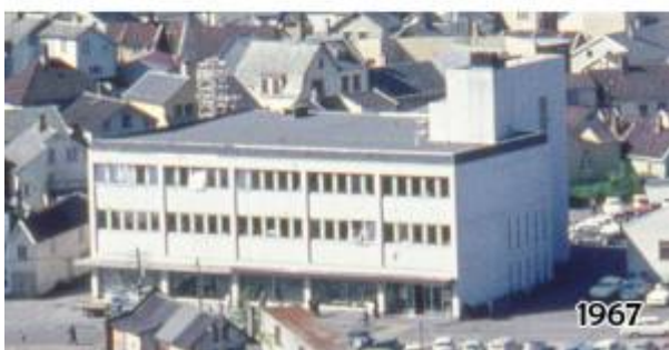
Bygging av Sentrumsgården trinn for trinn. Foto: Casper Feyling (farge) og Fotohuset (svart-hvitt), 1962-1967.
