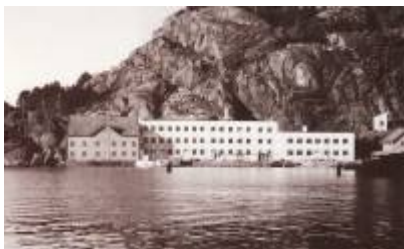
Den gjenoppbygde Eie Stentøifabrik etter brannen i 1938. Foto: Ukjent/DF
