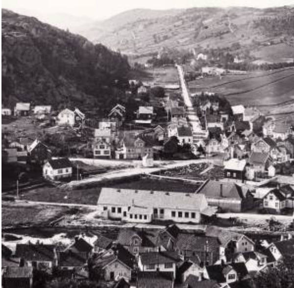
Det nyoppførte slakthuset ved Lundeåna. Foto: T. Sandstøl/DF(Utsnitt)
