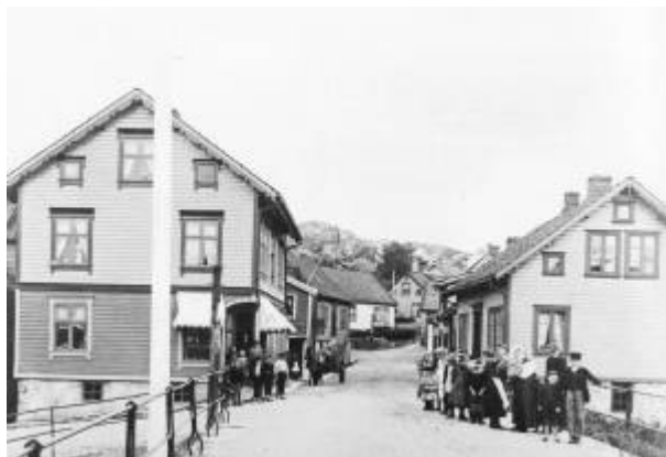
Damsgård bru, cirka 1895/96. Foto: P. A. Flak/DF
